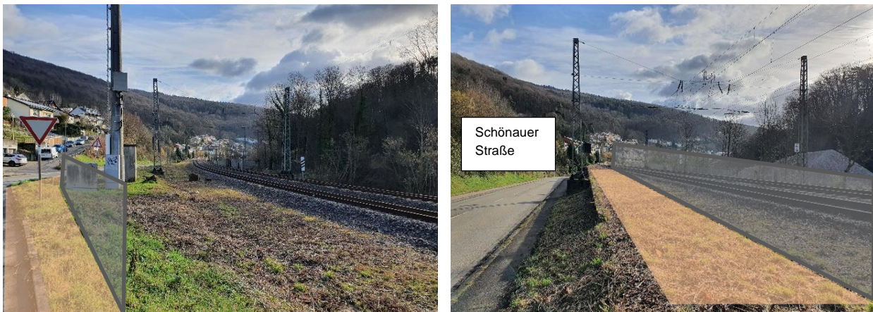
Abbildung 16: Bahntrasse am Mündungsbereich Forstweg in Schönauer Straße Blick Richtung Südosten (links), Bahntrasse an Schönauer Straße Blick Richtung Nordost (rechts)
