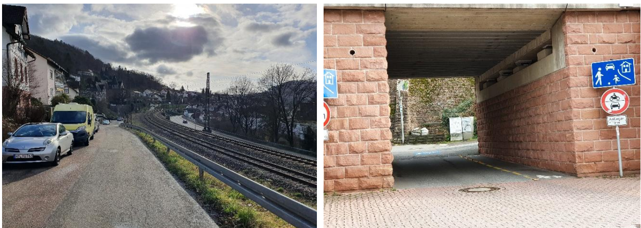
Abbildung 15: Hirtweg Blick Richtung Südosten (links), Unterführung am Ausbauende (rechts)
