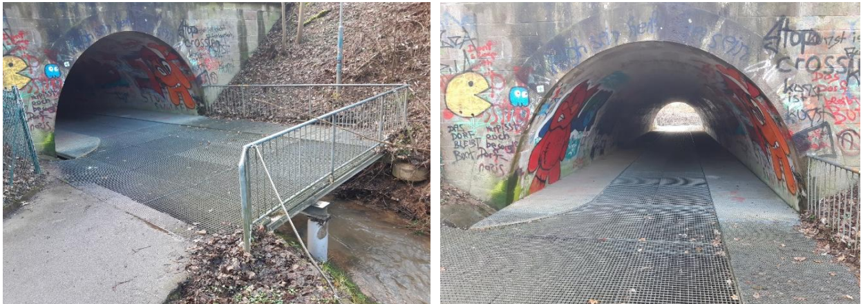
Abbildung 8: Variante 1b) Fuß-/Radweg wird oberhalb des Flusses geführt
