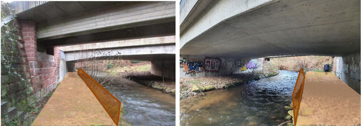
Abbildung 6: Forstwegbrücke und Bahnbrücke Blick Richtung Westen (links); Bahnbrücke Blickrichtung Osten (rechts) mit eingetragenen Rad-Fußweg und Stützmauer
