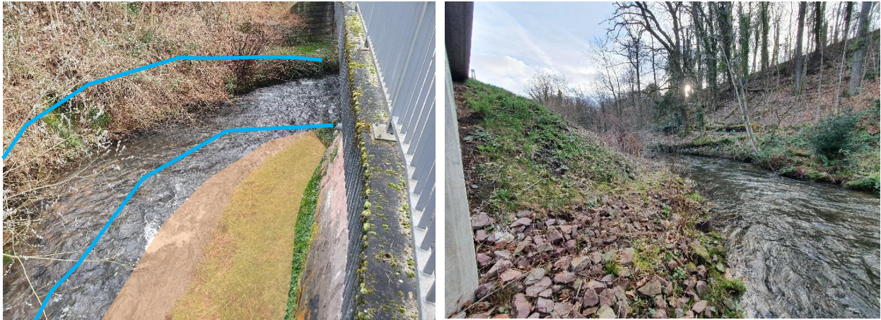
Abbildung 9: Bahnbrücke Blick Richtung Süden (links) mit veränderten Flussbett; Bahnbrücke Blickrichtung Norden (rechts)
