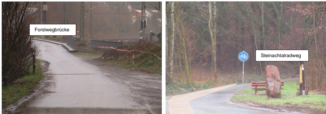
Abbildung 10: Forstwegbrücke Blick Richtung Norden (links); Ende Steinachtalradweg Blickrichtung Süden (rechts)
