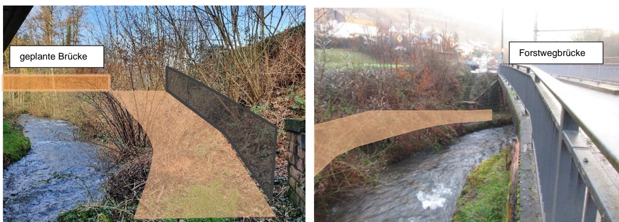
Abbildung 5: Forstwegbrücke Blick Richtung Ausbaubeginn (links); Blick entlang Forstwegbrücke (rechts) mit eingetragenen Rad-Fußweg und Gabionenwand
