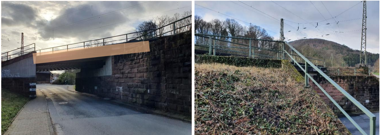
Abbildung 17: Bahnbrücke über Schönauer Straße Blick Richtung Südosten (links), Blick Richtung Westen (rechts)
