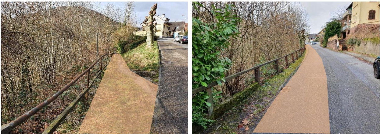
Abbildung 14: Mündungsbereich Trampelpfad in Hirtweg, Blick Richtung Südwesten (links), Hirtweg Blick Richtung Nordwesten (rechts)
