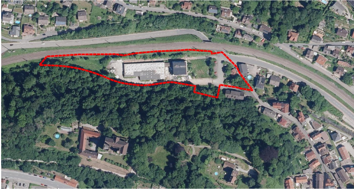
Abbildung 2: Bestandssituation vor dem Abriss der Gewerbebauten im Jahr 2022 (Geltungsbereich rot gestrichelt umrandet) (© Hessisches Landesamt für Bodenmanagement und Geoinformation)
